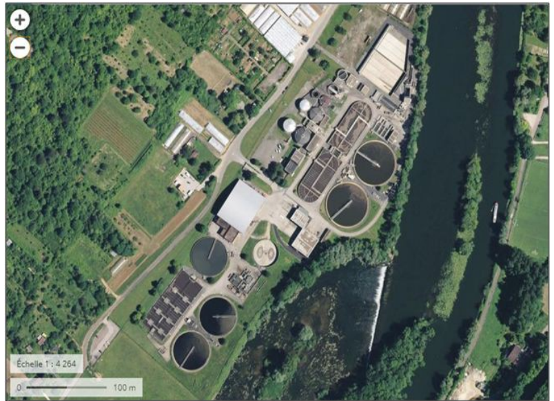
La Station d'Épuration de Port Douvot (Besançon) doc. Géoportail
