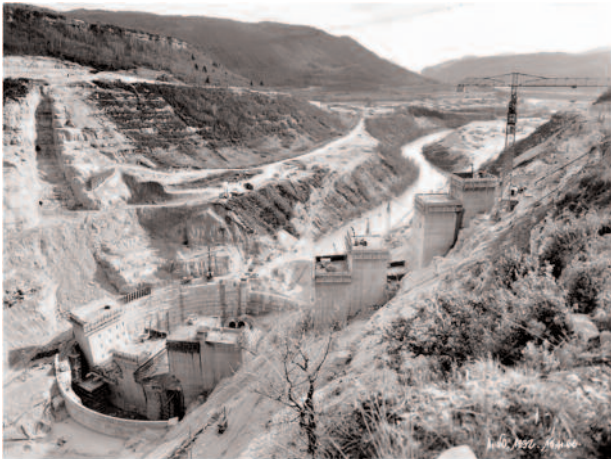
Travaux de construction du barrage de Vouglans (archives, 1966)
