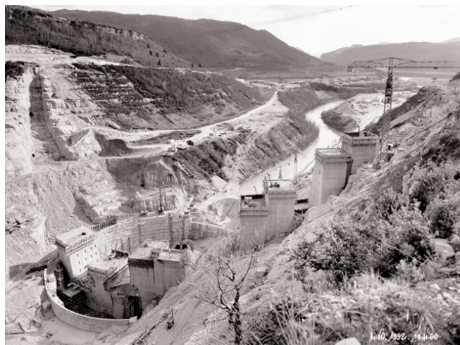
Travaux de construction du barrage de Vouglans (1966)
